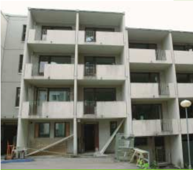
Järvenpäässä vanhoja aravavuokra-asuntoja sekä puretaan että kunnostetaan.
